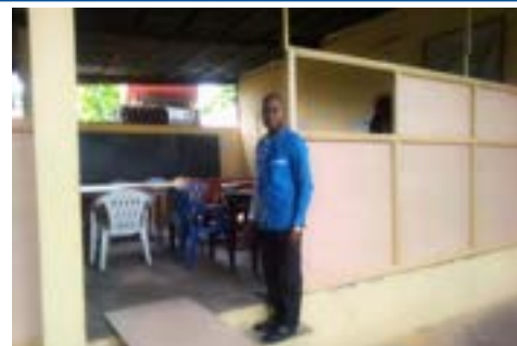
P. Arnaud visite le chantier de la cantine
