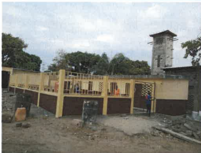
Au dessus, construction de nouvelles salles de classes
