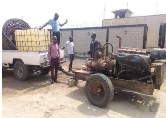
Travaux d'agrandissement du forage à Vindoulou
